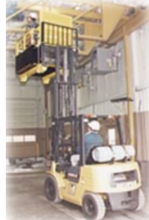
Auf den Gabeln eines Flurförderzeuges angehobene Arbeitsbühne
