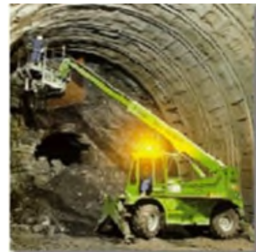
Arbeitsplattform, die mit einem Teleskopstapler zusammengebaut ist
